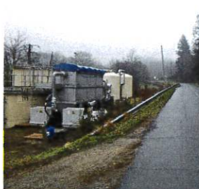
Situation face aux risques de la station de la Meynardie à La Coquille
